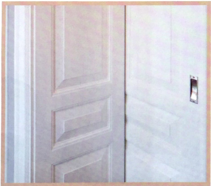
Een oude deur diende als voorbeeld voor de profilering.
