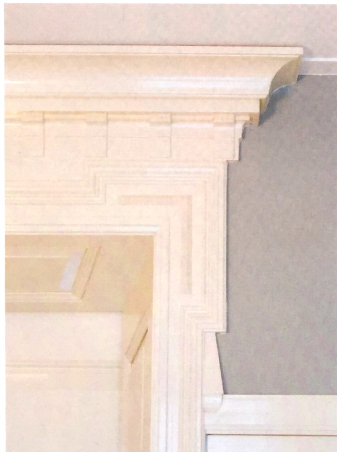
De originele profilering werd vakkundig nagemaakt.
